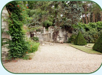
L'un des pavillons du Prieuré, envahi par la végétation.
