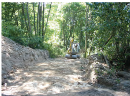
Construction d'une « route »
