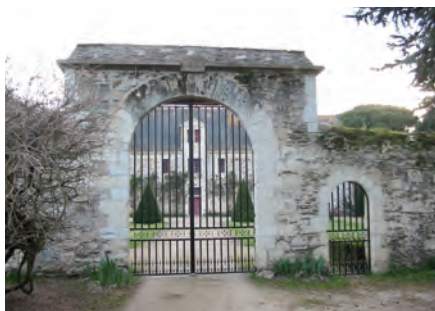
Grille du prieuré restaurée
