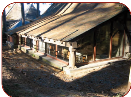
Sacristie de la chapelle du prieuré en cours de travaux
