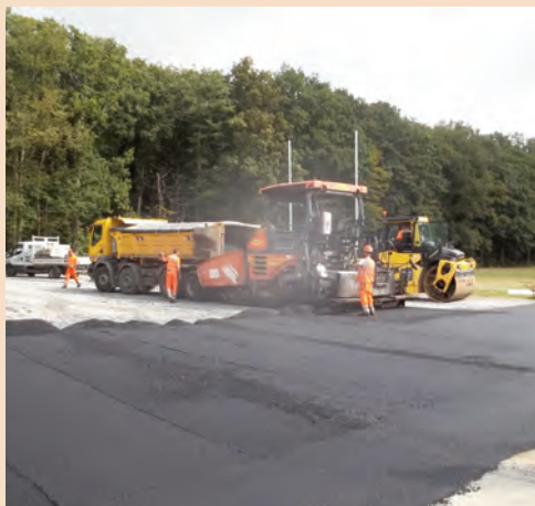
Réfection du parking
